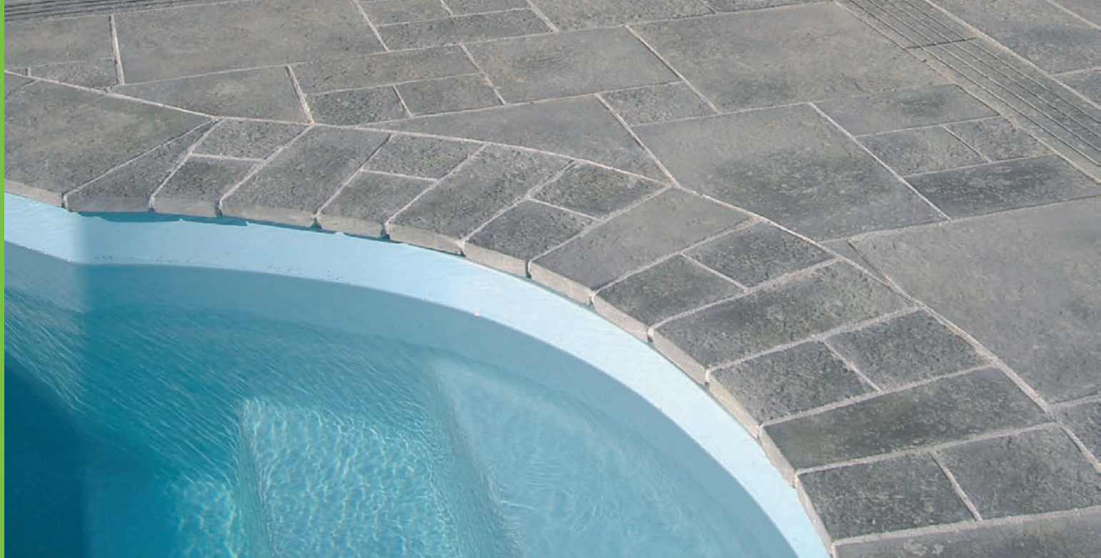
Les dalles de cette margelle ont été taillées une à une
