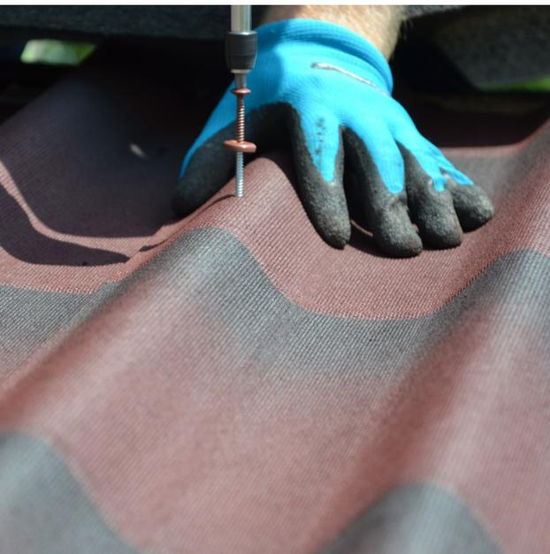
Côté fixation, c'est à l'installateur de choisir en fonction de la qualité du support. ONDULINE propose des vis universelles de 60 mm munies de leur collerette d'étanchéité. **Pour assurer une finition soignée de la toiture, le fabricant a également développé des rives et des faîtières associées. Ces dernières, proposées dans le même matériau et les mêmes coloris que les plaques, permettent un rendu uniforme et harmonieux.**
