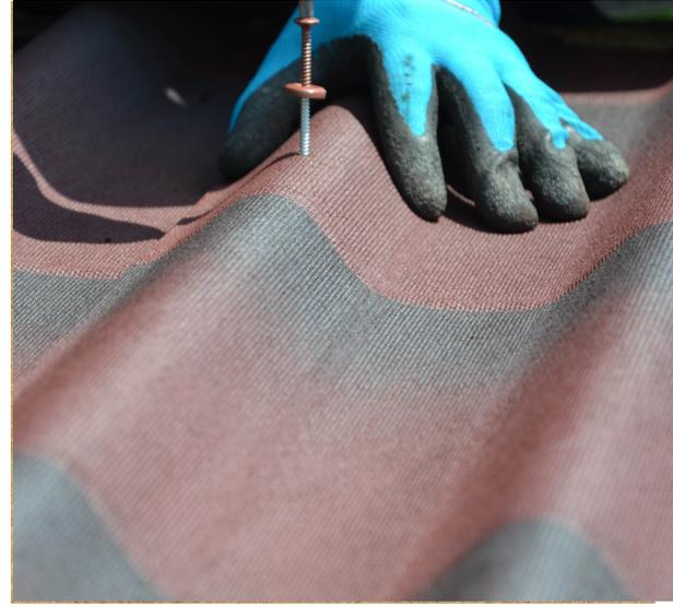
*Au plus près des attentes des bricoleurs, les nouvelles plaques ONDULINE EASYSTYLE® - composées à 50 % de matière recyclée - s'intègrent à la perfection aux différents aménagements grâce à leur bel aspect imitation tuile. Légère, souple, facile à manipuler et à installer, cette plaque bitumée garantie 10 ans offre une couverture durable et respectueuse de l'environnement.*
