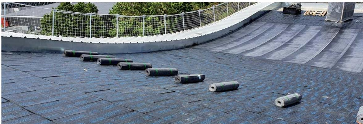
*Isolation en verre cellulaire FOAMGLAS® mise en œuvre sur les éléments porteurs en bac acier et en béton du Centre aquatique de Vitry-le-François. Les plaques isolantes, étanches à l'humidité (perméabilité du verre cellulaire = nulle), sont collées sur le béton et l'acier, et les plaques sont collées entre elles.*
